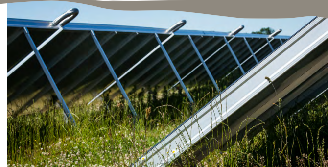
Zonthermiepanelen met bloemrijk grasland
