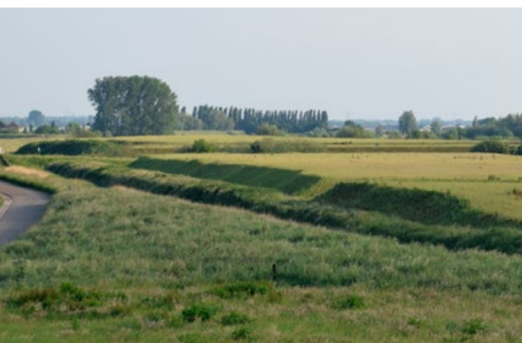
Huidige situatie in het plangebied - tijdelijk kleidepot
